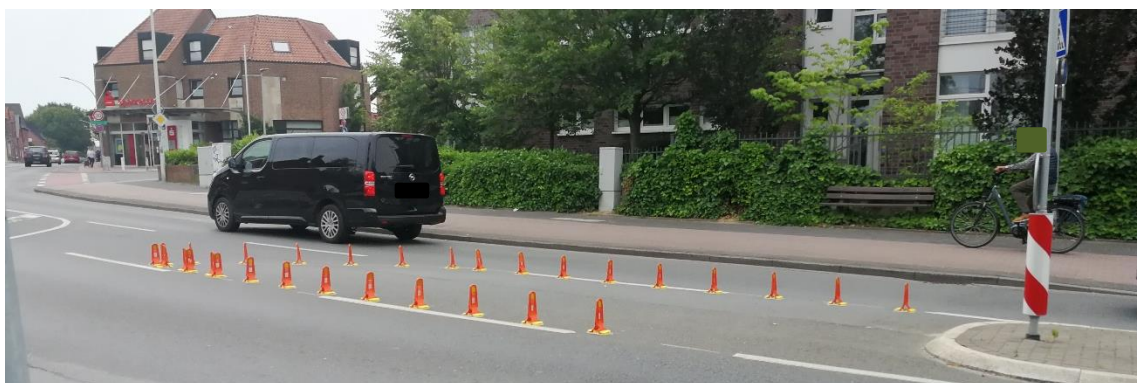
Abbildung 2: Einkürzter Linksabbieger an der Einmündung Im Hagenkamp/Münsterstraße.
